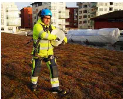
Gödsling av sedumtak.
